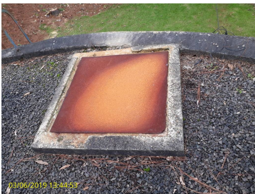
Foto 42 - Tampa de inspeção
