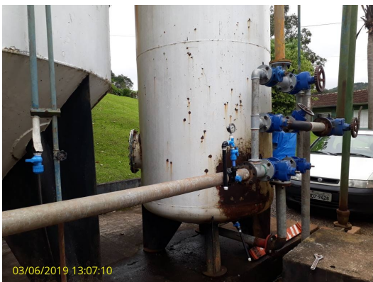
Foto 13 - Consertado os vazamentos nas instalações hidráulicas da ETA
