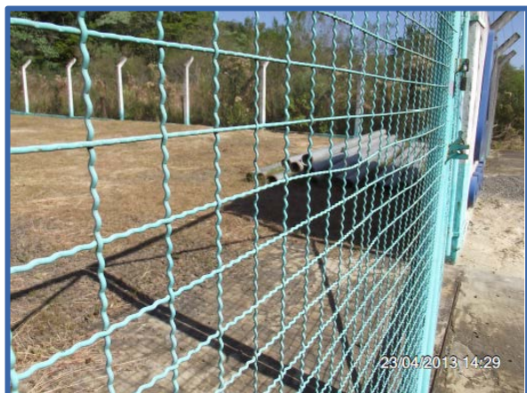
Imagem 7: Tubulações depositadas no entorno do Poço 01.
