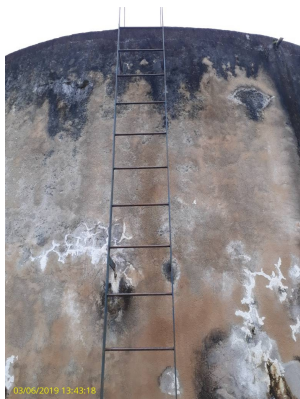
Foto 45 - Escada de acesso
