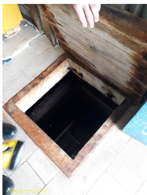
Foto 29 - Tampa da câmara de inspeção em madeira
