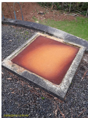
Foto 40 - Tampa de inspeção
