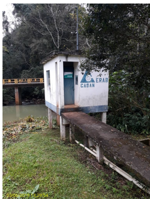
Foto 6 - Acesso à ERAB
