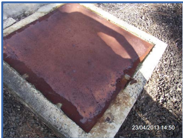
Imagem 35: Tampa da abertura de inspeção reservatório R 01.
